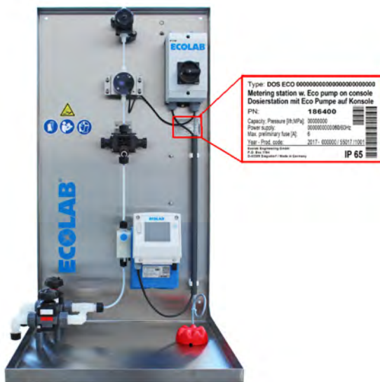
Abb. 2: Dosierstation mit Typenschild
