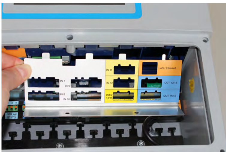
Fig. 95 : Démontage de la tôle de recouvrement
