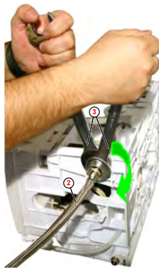
Abb. 4: Anschluss Hauswasserversorgung
